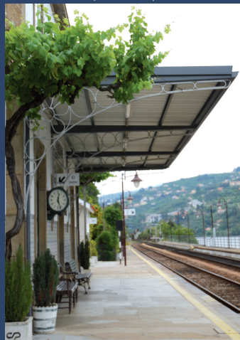
Plataforma da estação / Station platform
