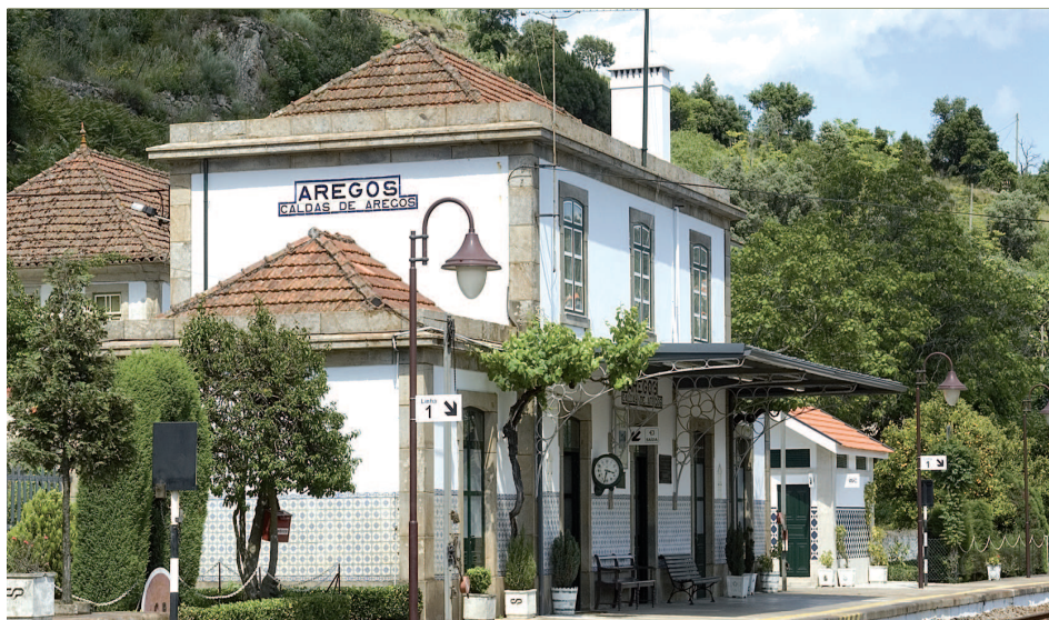
Estação de Aregos [Tormes] / Aregos Station
